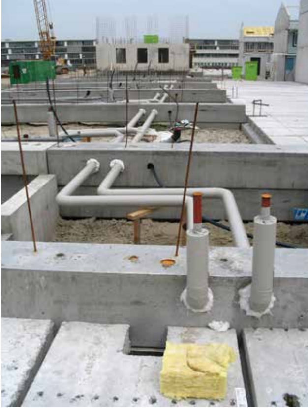
Sparingen voor stadsverwarmingsleidingen.
