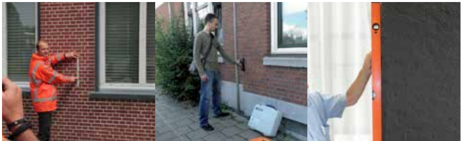
Figuur 2-1a, b, c lintvoegwaterpassing, lintvoegmeting en scheefstandmeting
